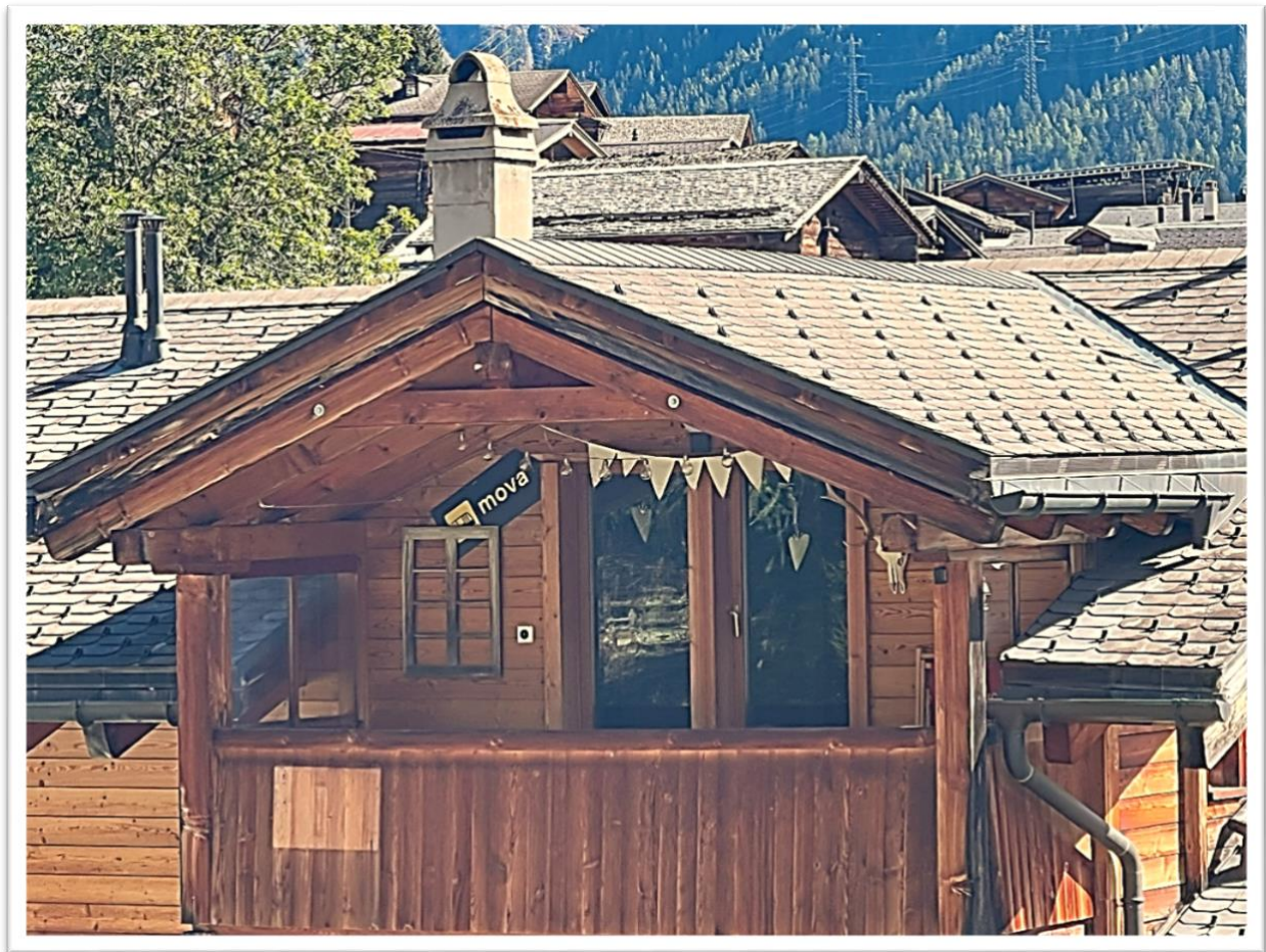
Haus Binelti Antoniusstrasse 14 3985 Münster VS
