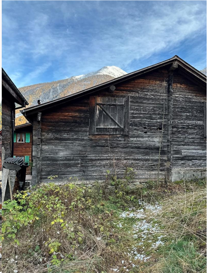
Ansicht Stallhälfte Norden
