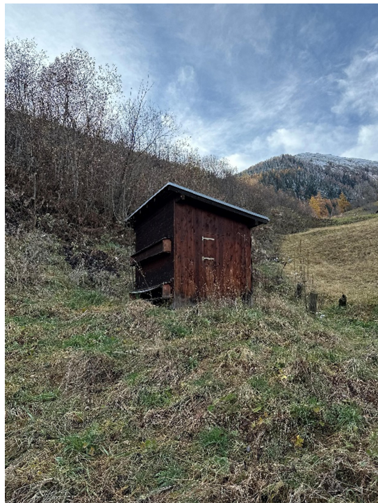
Kleines Gartenhäuschen auf dem Grundstück
